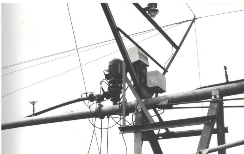
**Рис. 6 - Бустерный насос на последней опоре дождевальной машины**
