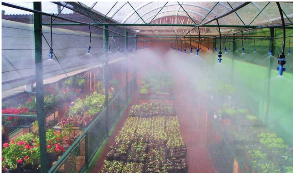
Рисунок 3 - Общий вид системы микрождевания в теплицах
